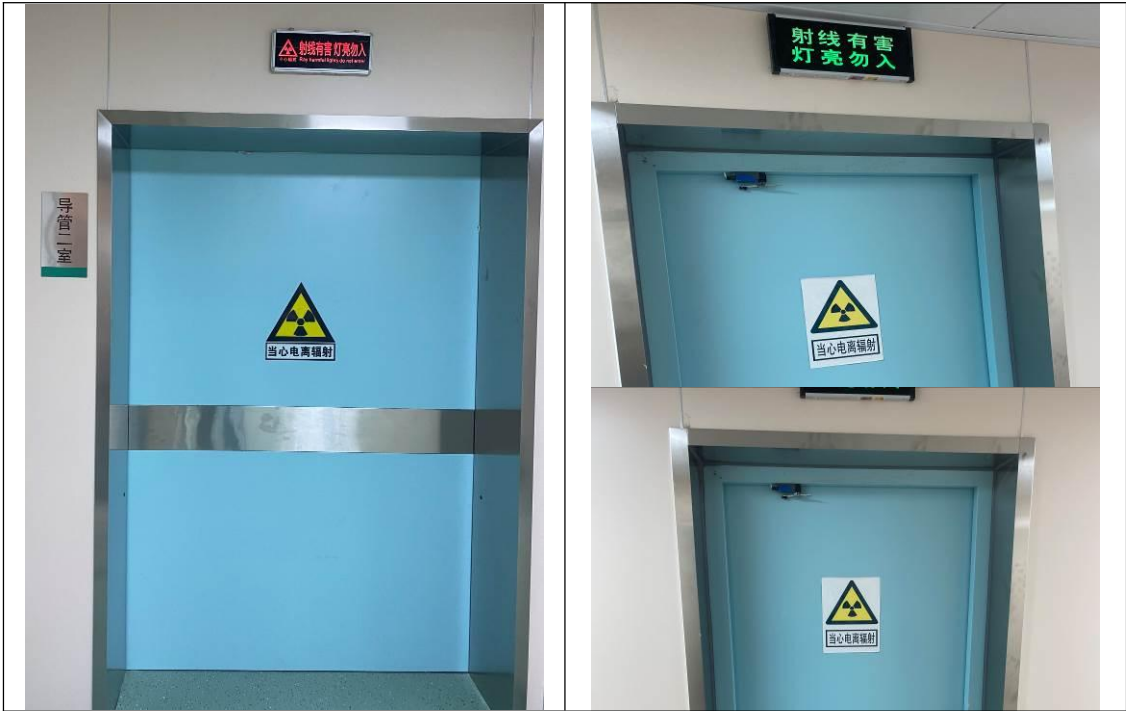
警告标志等辐射防护设施
